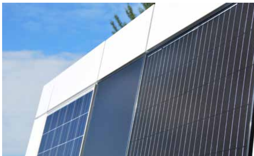
Ieder solarpaneel is één op één uitwisselbaar en functioneert onafhankelijk van elkaar.
