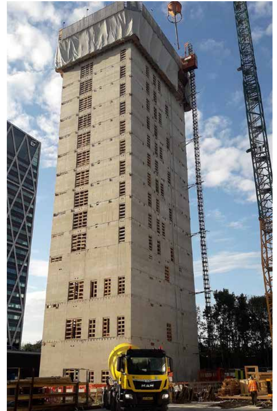
In opdracht van bouwbedrijf Dura Vermeer produceerde Gleitbau de volledige betonkern voor het nieuwe hoofdkwartier van het Europese Geneesmiddelen Agentschap (EMA) in Amsterdam.
