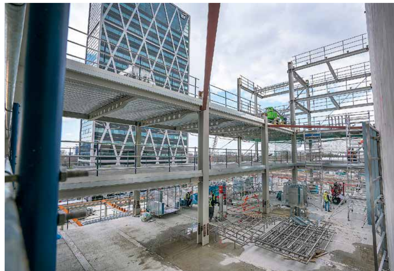
Om de kern wordt het gebouw opgebouwd met een staalconstructie en staalplaatbetonvloeren.
