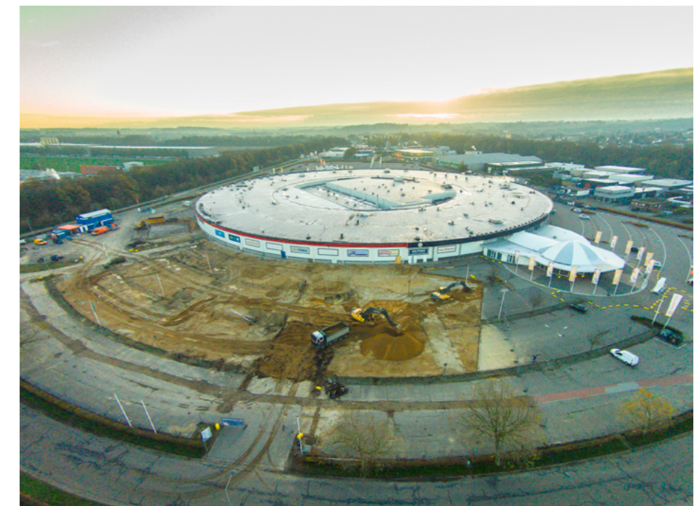
Situatie bij aanvang van de bouw toont goed de oorspronkelijke vorm van Makado
